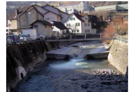
Restwassermesstelle Kontrolle des Abflusses zur KSL
