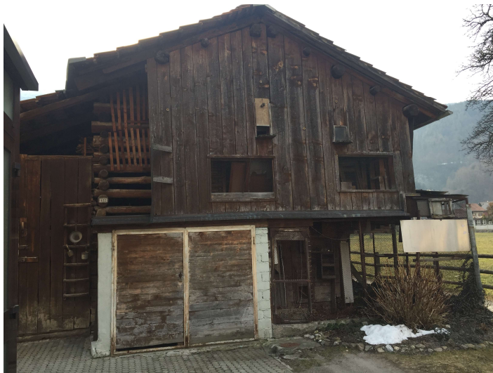
Tubä-Seppis Stall (leichtes und nur mit Beil bearbeitetes Bauholz, erbaut wohl in der ersten Hälfte des letzten Jahrtausends)
