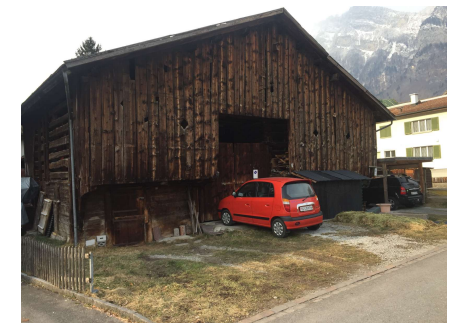
Stall ohne Eisen (Nägel) gebaut
