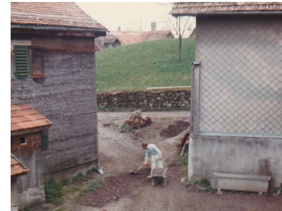
Arbeiten am Ilgenweg (gezeigte Gebäude abgebrannt)
